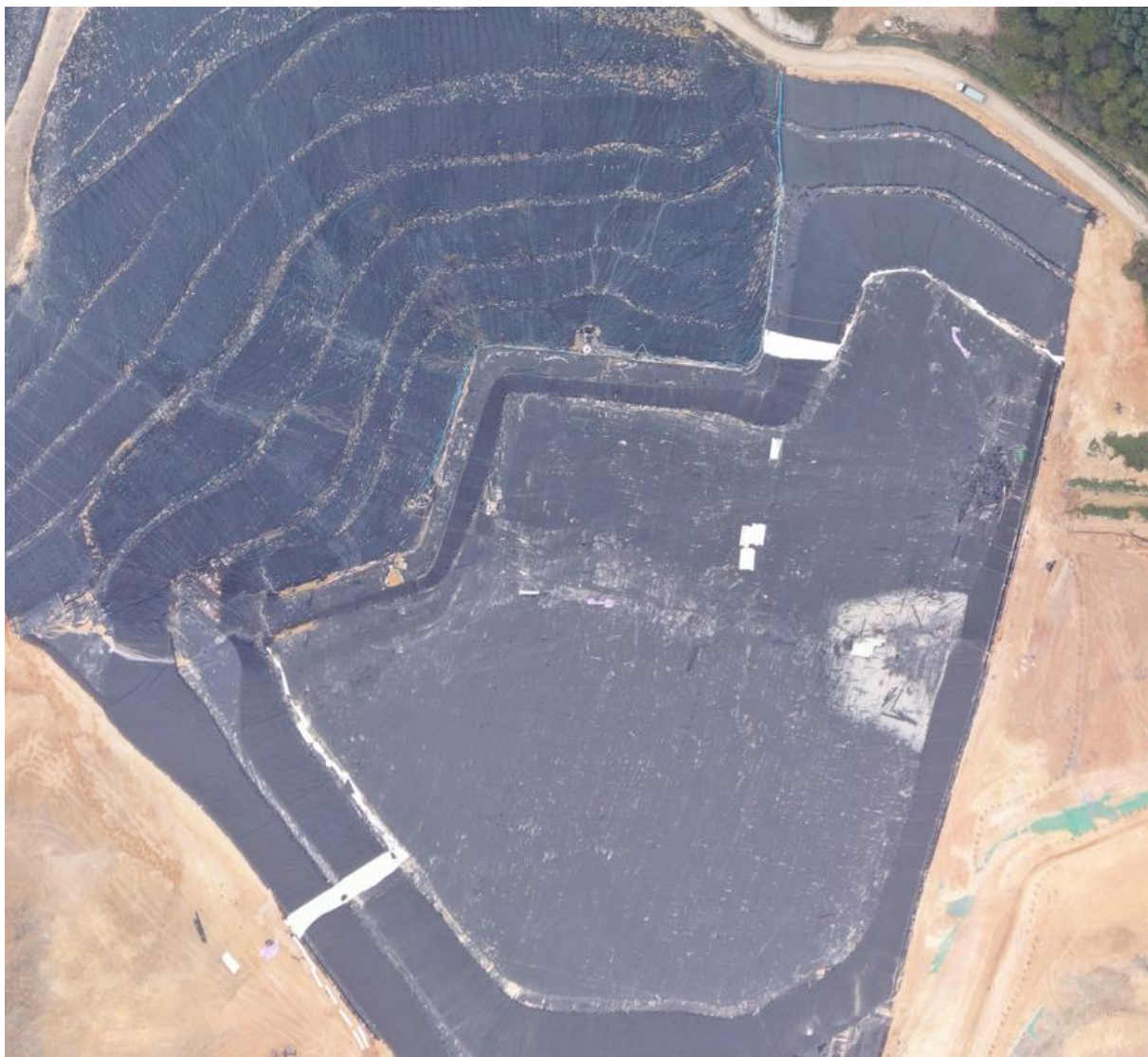
图 4.3-13 开挖完成并铺设防渗系统参考图
